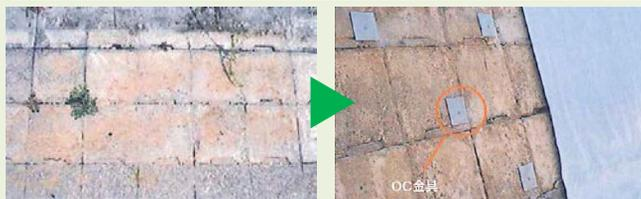
●水路線形に合わせて施工でき、傾斜部の場合にも簡単に施工できます。
